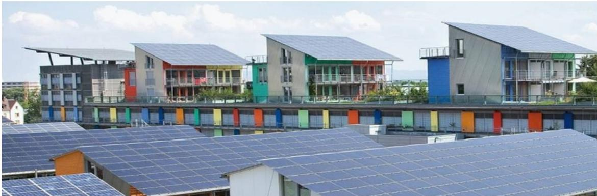
Mehrgeschoss-Bauweise mit maximaler Flächenaktivierung zur Erzeugung von Solarstrom durch Pultdach. Anwendbar im Neubau, ebenso aber bei grundlegender Gebäudesanierung/Aufstockung. Beispielhaft übertragbar auf die geplante Aufstockung am Schulstandort Elisabethenschule Marburg. Die Fläche für die Solarstromgewinnung kann mindestens verdoppelt werden gegenüber der bisherigen Nutzung. Ungeschmälert kombinierbar mit der Re-
