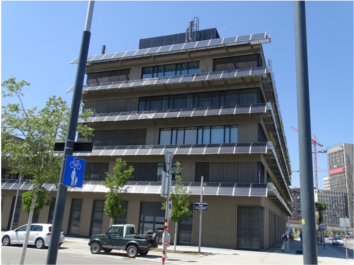
Beispiel einer Fassadennutzung für Solarenergie auch als passives Bauelement zur Beschattung von Fensterfronten zum Schutz der Räume vor Überwärmung, Wien, Seestadt 2019
