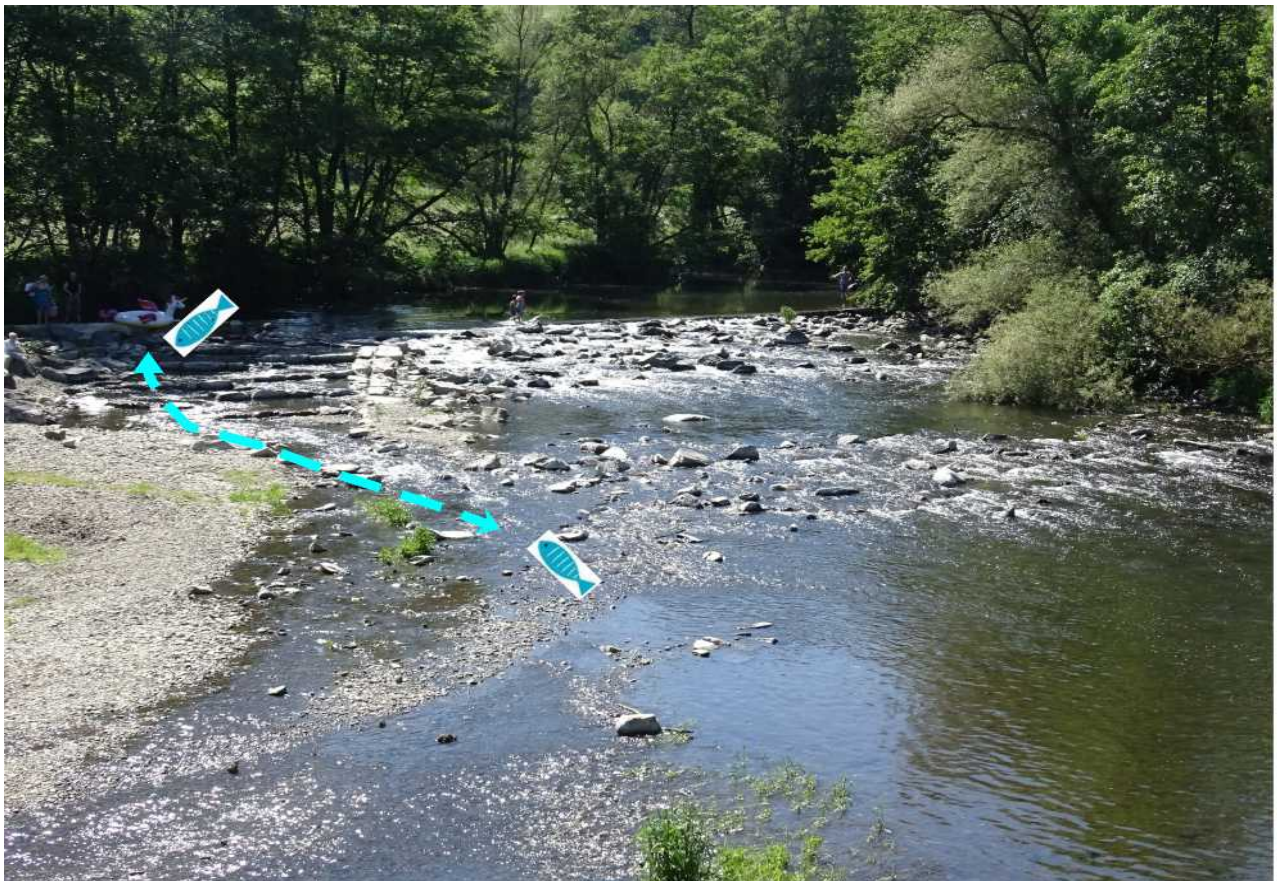
Umgebaute Wehranlage Kernbach, Totale mit Steinschüttung als „Rauhe Sohlgleite“ und Fischpass, Zustand bei Niedrigwasser 2019
