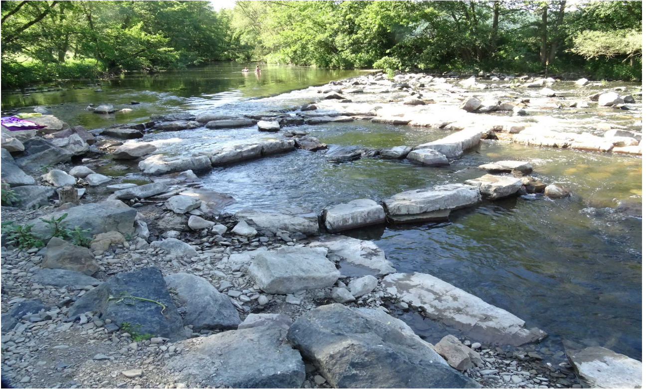
Detailbild des „Fischpass“ Wehranlage Kernbach, Niedrigwasser 2019
